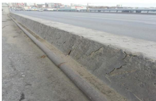
**Рис. 3.** Отслаивание верхнего слоя цементобетонного покрытия от поверхности ограждения на Коммунальном мосту г. Новосибирска
